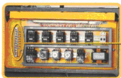
3. необходимо проверить надежность фиксации и правильность подсоединения провода заземления.
